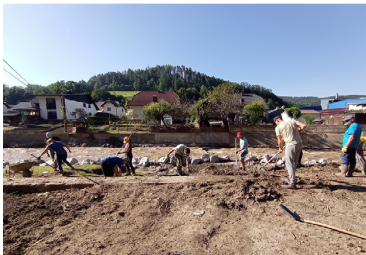
NA DELOVNI AKCIJI PO POPLAVAH 2023.
